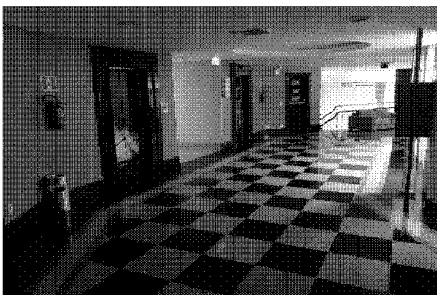
FOTO 122: 2º PAVIMENTO - HALL
