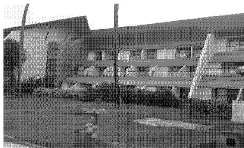
FOTO 02: FACHADA FRONTAL A PRAIA
