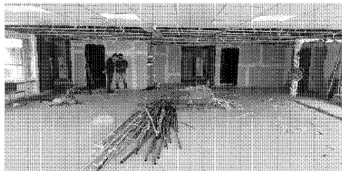
FOTO 16: SALA WYNDHAM EM REFORMA
