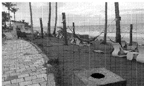
FOTO 01: ESTRUTURA DE PRAIA DO RESORT
