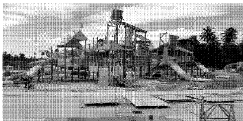
FOTO 25: PARQUE AQUÁTICO EM CONSTRUÇÃO
