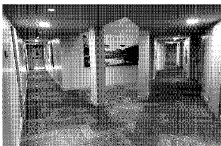
FOTO 93: TORRE 2, 2º PAVIMENTO - HALL
