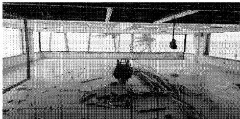
FOTO 15: SALA WYNDHAM EM REFORMA
